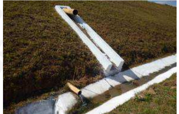
Foto 10 - DHP's instalados nas bermas abaixo da berma de recuo, cujo fluxo é lançado diretamente sobre as canaletas de drenagem superficial.
