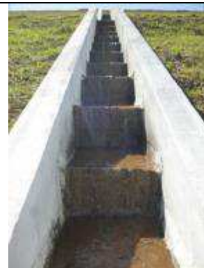
Foto 12 - Descidas d'água abaixo da berma de recuo, limpas e desobstruídas.
