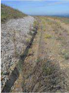
Foto 13 - Canaletas e descidas d'água acima da berm de recuo. Alguns trechos assoreados.
