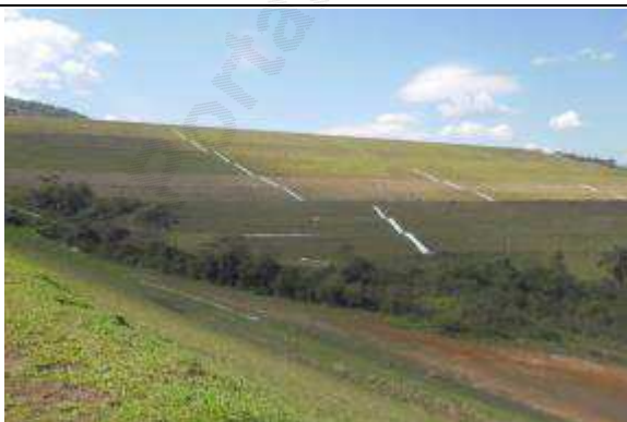
Foto 5 - Vista geral do talude de jusante.
