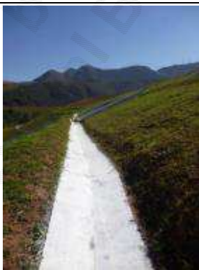
Foto 11 - Canaletas abaixo da berma de recuo, limpas e desobstruídas.
