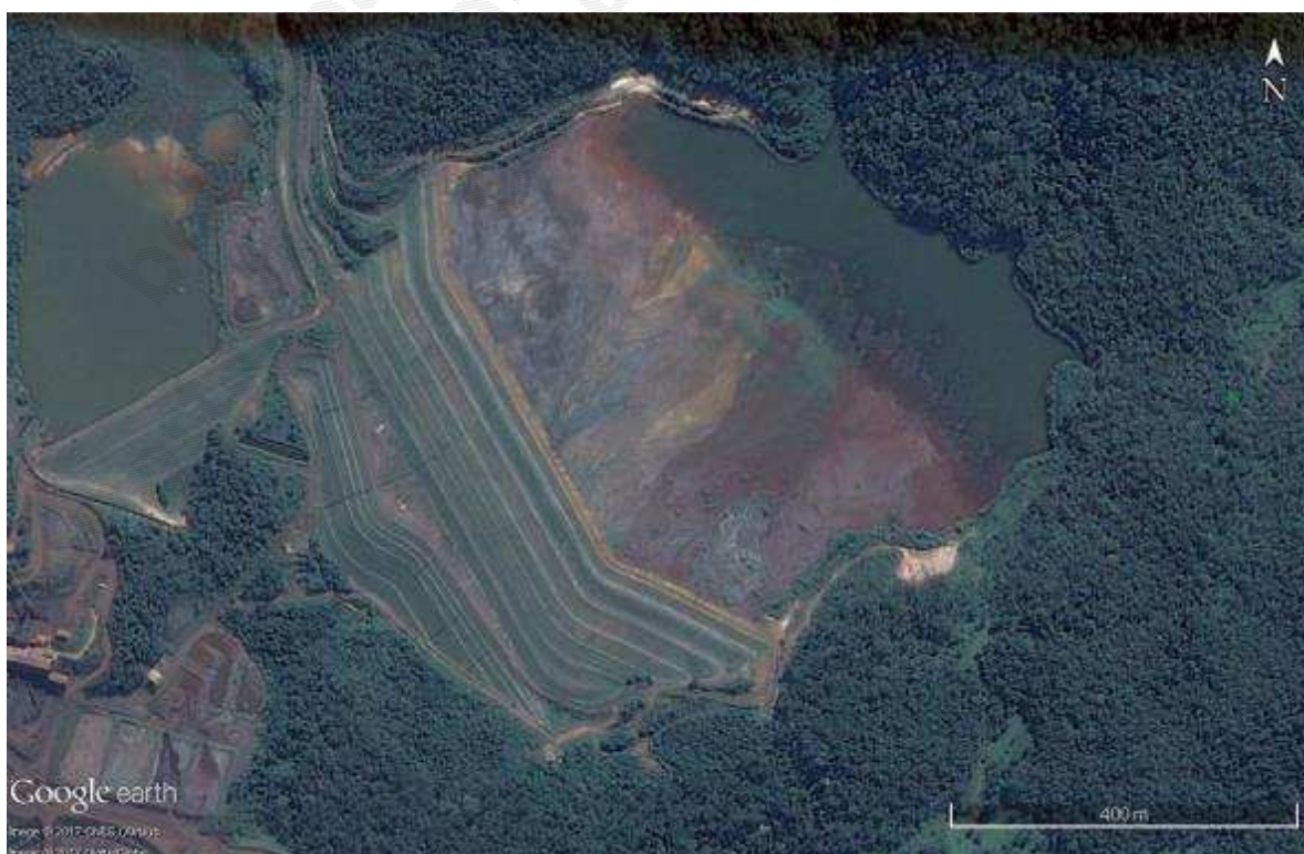
Figura 2 – Vista geral do reservatório da Barragem I (Fonte: Google – Setembro/2016).
