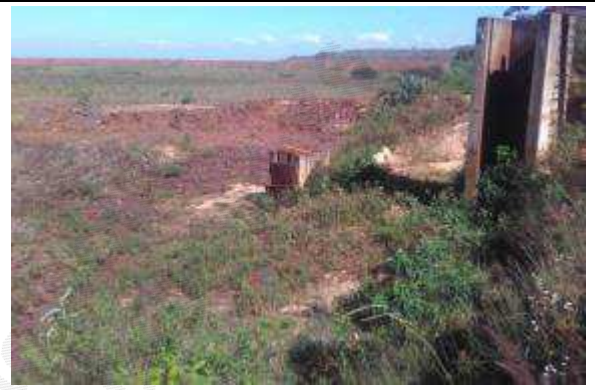
Foto 8 - Torres de tomada d'água do sistema extravasor, sem anomalias. Classificação quanto EC (“confiabilidade das estruturas extravasoras”): 0.
