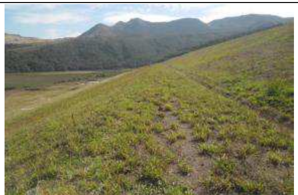
Foto 6 - Vista do talude de jusante, acima da berm de recuo, com algumas falhas na proteção vegetal. Classificação quanto ao EC ("deterioração dos taludes/paramentos"): 2.
