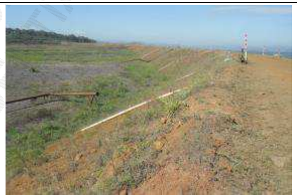
Foto 4 - Vista do talude de montante no sentido da ombreira esquerda, com vegetação mais alta em alguns pontos e falhas em outros. Classificação quanto ao EC ("deterioração dos taludes/paramentos"): 2.
