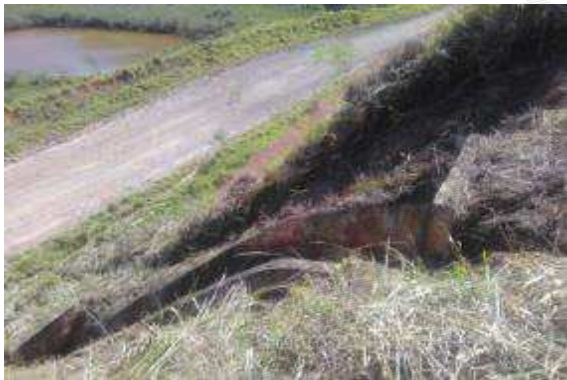
Foto 9 - Saída da galeria do sistema extravasor, em canal a céu aberto.
