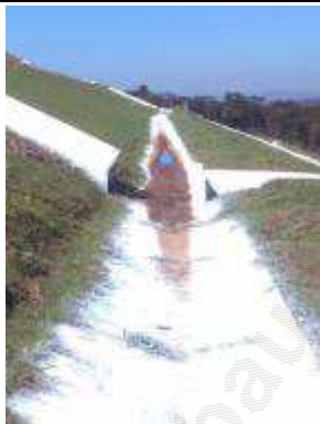
Foto 15 - Alguns trechos de canaletas de drenagem superficial com acúmulo de água.
