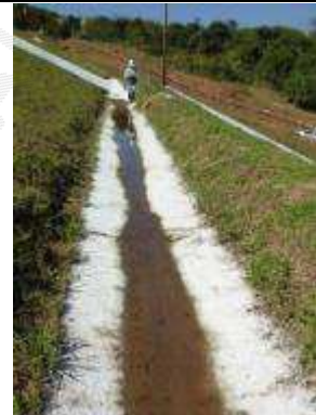
Foto 16 - Alguns trechos de canaletas de drenagem superficial com acúmulo de água.
