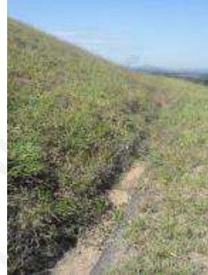
Foto 14 - Canaletas e descidas d'água acima da berm de recuo. Alguns trechos assoreados.
