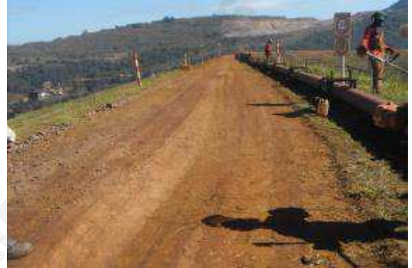
Foto 2 - Vista da crista da barragem, no sentido da ombreira direita. Classificação quanto ao EC ("deformação e recalques"): 0.
