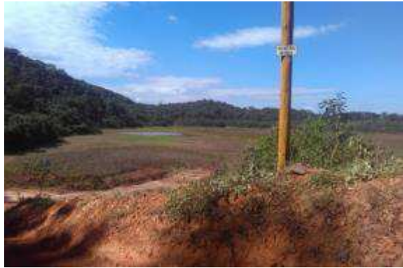
Foto 1 - Pequeno espelho d'água na parte montante do reservatório. Reservatório com praia superior a 150 m.
