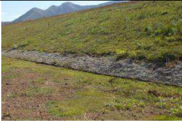
Foto 7 - Vista do talude de jusante, acima da berma de recuo, com vegetação mais alta em alguns pontos. Classificação quanto ao EC (“deterioração dos taludes/paramentos”): 2.
