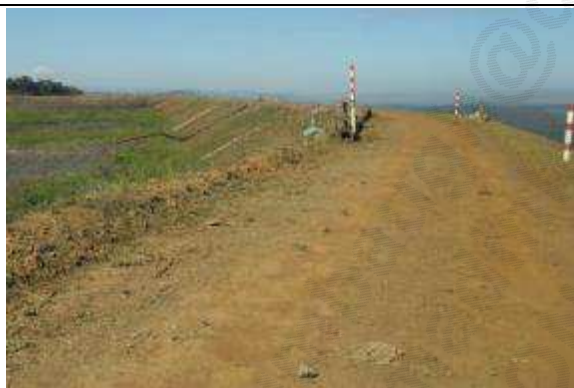
Foto 3 - Vista da crista da barragem, no sentido da ombreira esquerda. Classificação quanto ao EC ("deformação e recalques"): 0.
